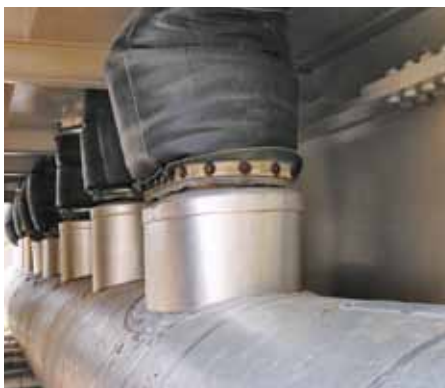
Трубный проход с тканевыми компенсаторами KE®, установленными на внешней изоляции трубы.
