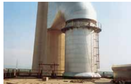
Компенсатор для присоединения в газоходах.
