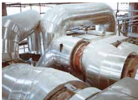
Установка тканевого компенсатора KE® на целлюлозно-бумажном заводе.
