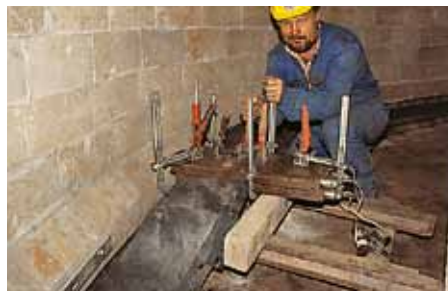
Герметизация стыков футеровки в газоходах.
