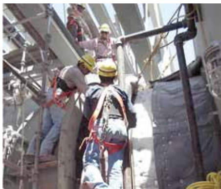
Тканевый компенсатор KE ® , установленный на магистрали.
