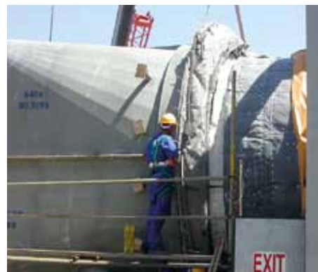
Установка тканевого компенсатора KE ® .
