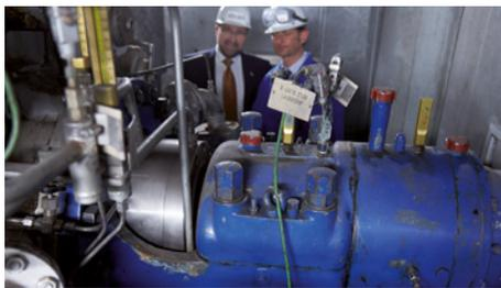
Торцовое уплотнение EagleBurgmann **DF-SAF14/188** с алмазным покрытием используется в котловом питательном насосе электростанции в г. Фёрде (ФРГ), работающей на каменном угле, и компания-оператор абсолютно довольна результатом. Условия эксплуатации:  $p = 21$  бар (305 PSI);  $t = 158$  °C (316 °F);  $n = 5.100$  мин<sup>-1</sup>.
